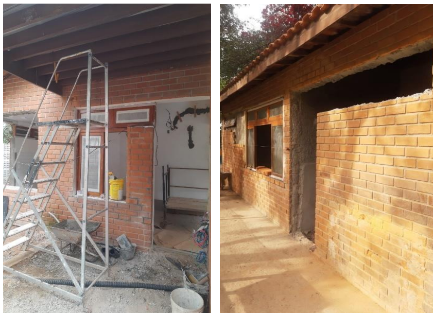
Figura 20: Obras na administração
